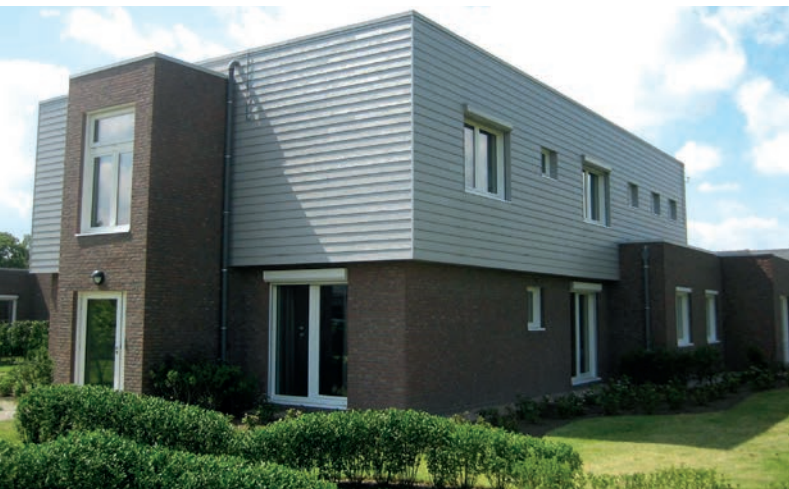
Een schoolvoorbeeld van een passiefgebouw in de zorgsector? Dat is campus De Vluchtheuvel van Rotonde vzw (Stabroek), een organisatie voor volwassenen met een beperking. Foto © Cenergie
