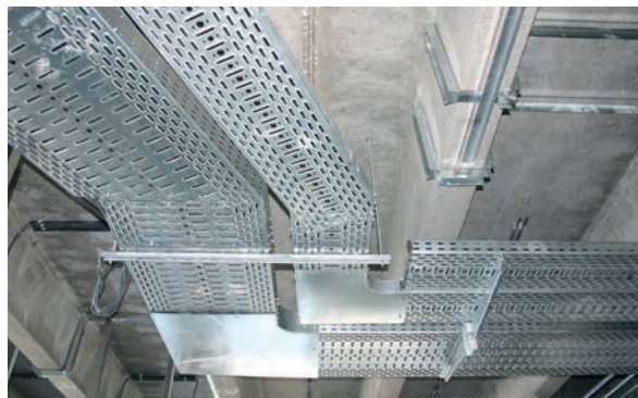
Draadgoten, kabelgoten en vloergootsystemen in de 'Cliniques Universitaires Saint-Luc UCL' in Woluwe (Beeld Vergokan)
