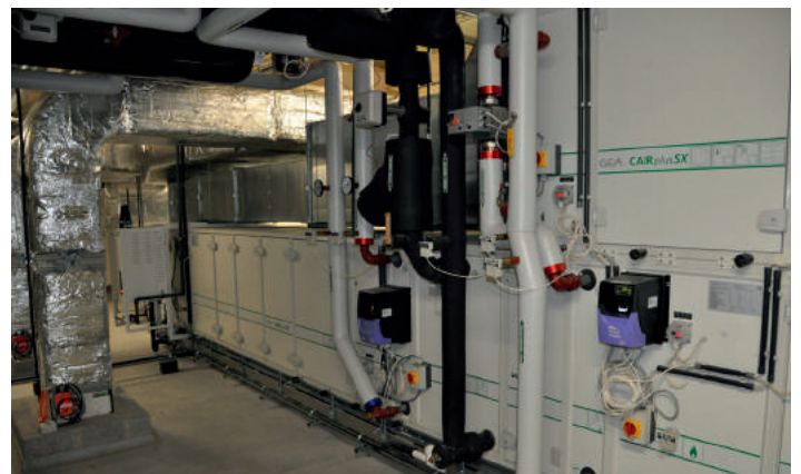
Het dak werd verhoogd om alle technieken vlot te kunnen implementeren
