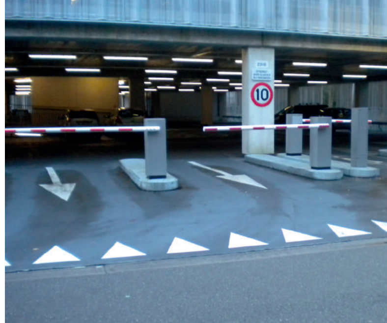
Slagbomen aan de toegang tot het chromosoomvormige ZOL-parkeergebouw
