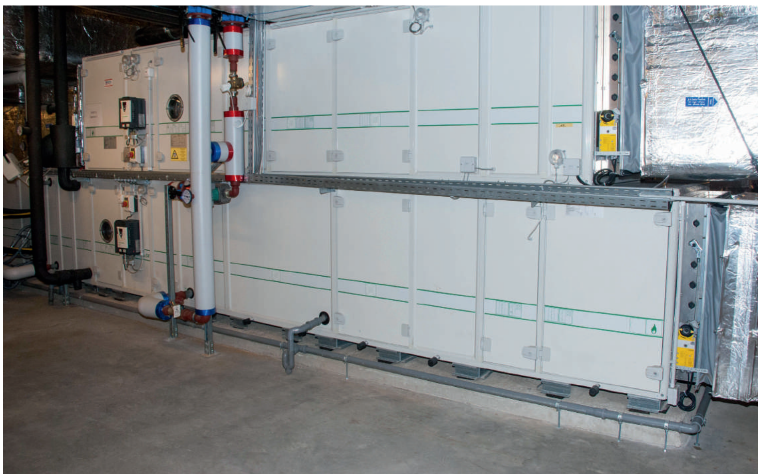
Hygiëneluchtgroep CAIRplus met dubbele platenwisselaar (Ecotwin)
